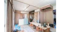
空き家の床や壁紙、天井を剥がしてバリアフリー設計に
